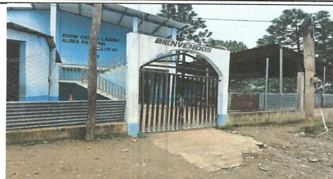
Foto 2: Se mejorará la instalación de un portón de acceso para mayor seguridad
