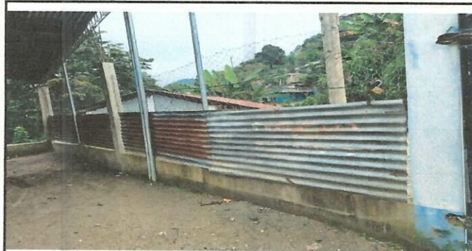
Foto 1: Se mejorará y ampliara el muro perimetral del centro Educativo
